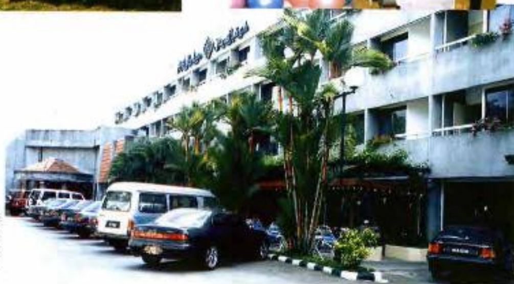
Hotel Perdana Kota Bharu yang bestarif Empat Bintang merupakan hotel milik penuh PKINK.
